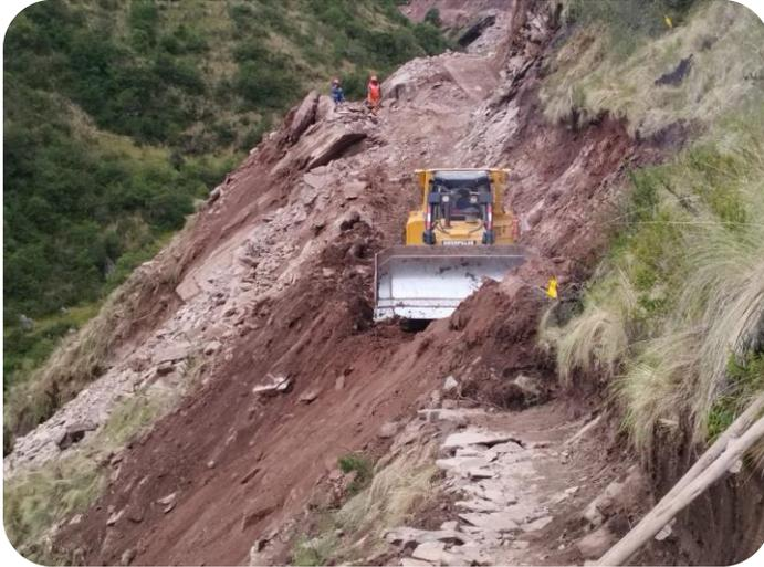
**Imagen 01.** Corte y apertura de la vía con tractor oruga.
