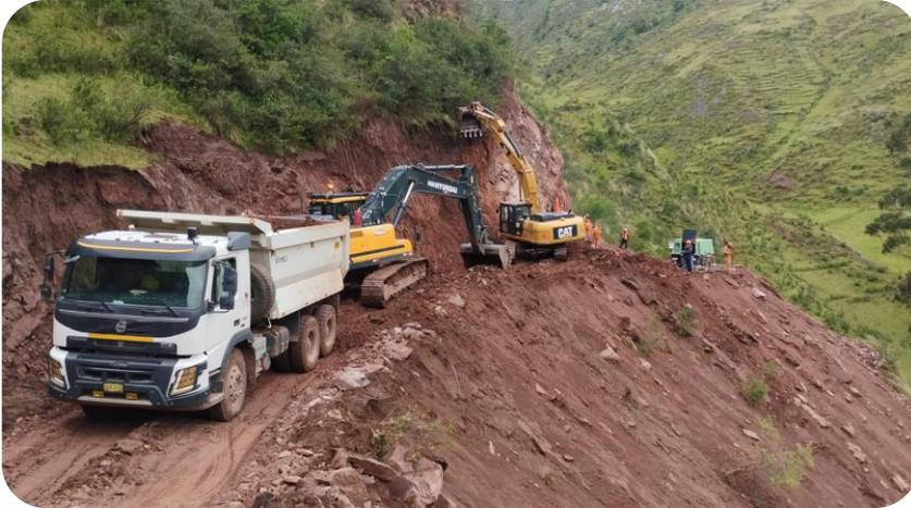
**Imagen 03.** Carguío y eliminación de material excedente.
