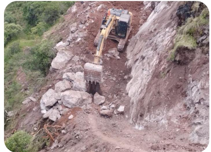
**Imagen 02.** Acopio de material excedente para su posterior eliminación con excavadora.
