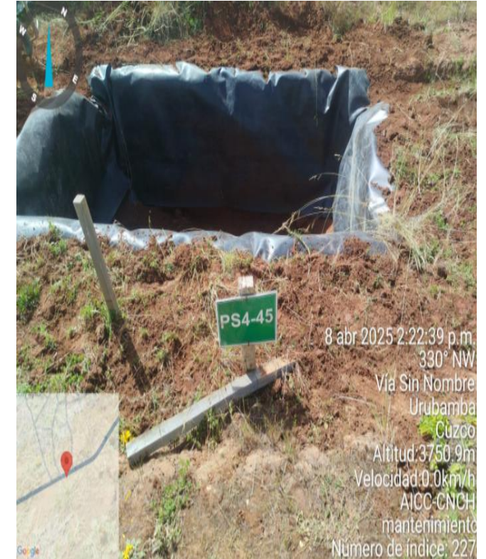
Mantenimiento y forrado de Pozas de sedimentación con Geomembrana.
