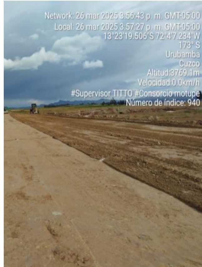
Extendido de material de relleno de protección de grietas
