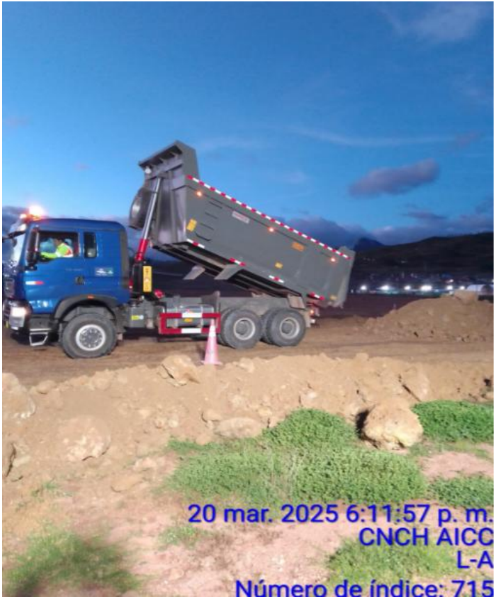
Descarga de material para la protección de grietas
