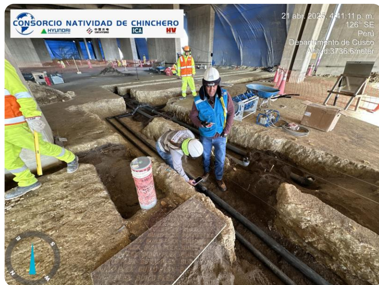
Liberación de termofusión de tuberías de HDPE para redes de agua potable y tratada
