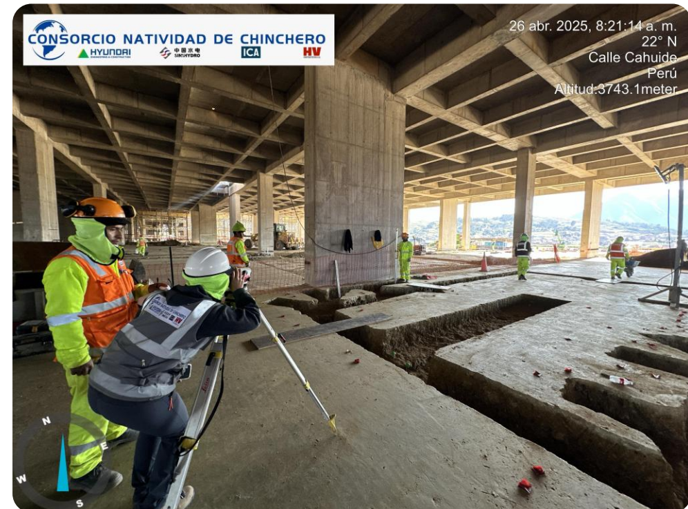
Liberación de excavación de zanjas para redes de desagüe Release of trench excavation for sewage networks
