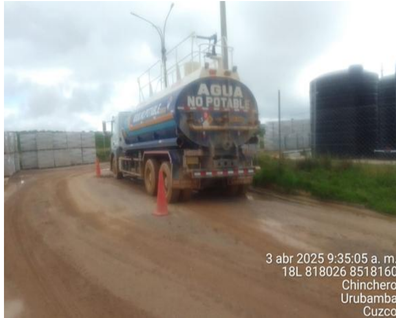
Reúso de agua de la Planta de Tratamiento (Cero Vertimiento).
