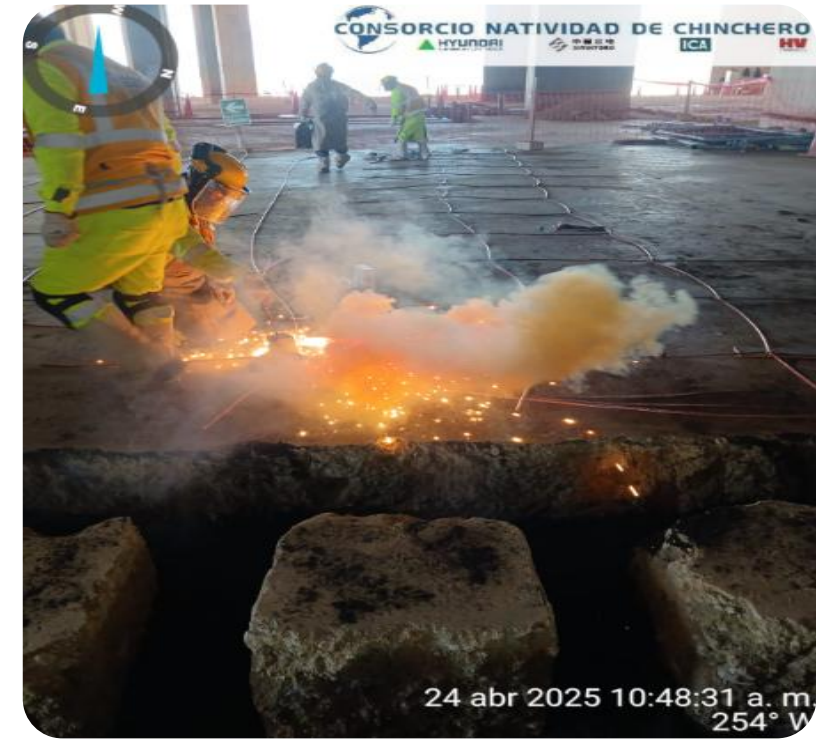
Soldadura exotérmica para malla a tierra Exothermic welding for grounding mesh
