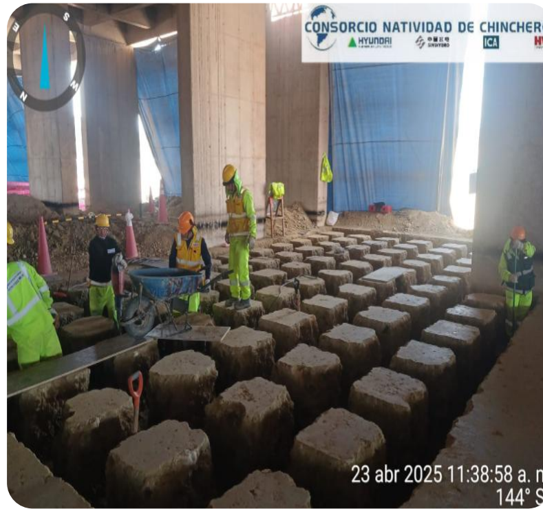
Excavación de malla a tierra Measurements of grounding mesh
