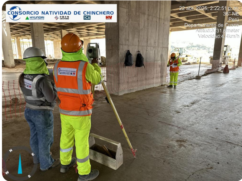
Liberación de trazo y replanteo topográfico para redes de desagüe Release of layout and topographic staking for sewage networks
