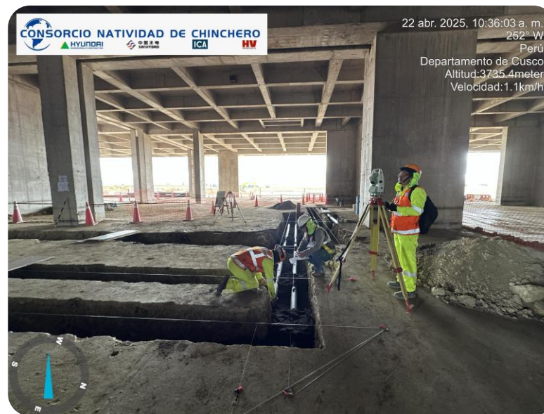
Liberación de instalación de tuberías de PVC, PP Y HDPE para redes hidrosanitarias
