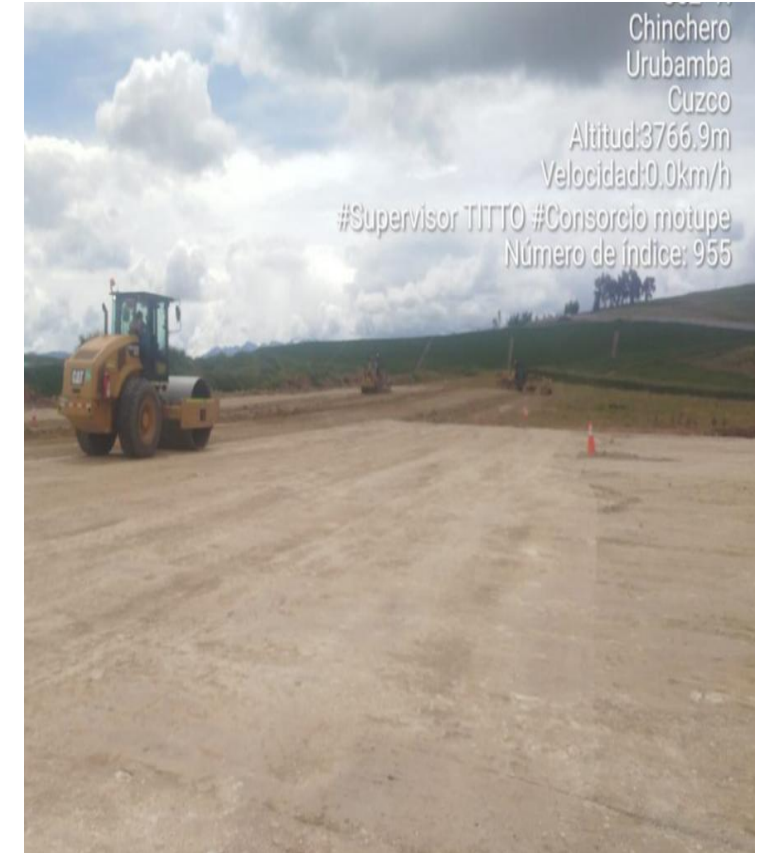
Sellado y compactado de relleno de grietas
