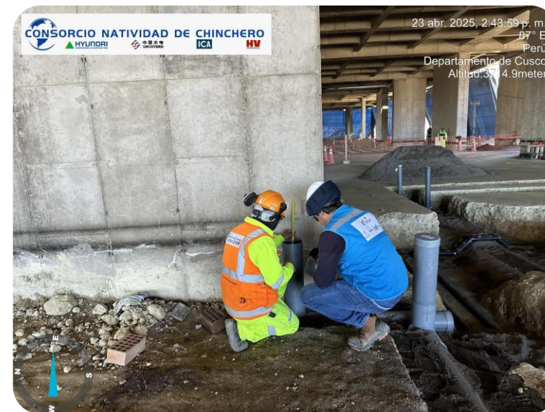
Liberación de prueba de estanqueidad para redes de desagüe, desagüe graso y drenaje pluvial
