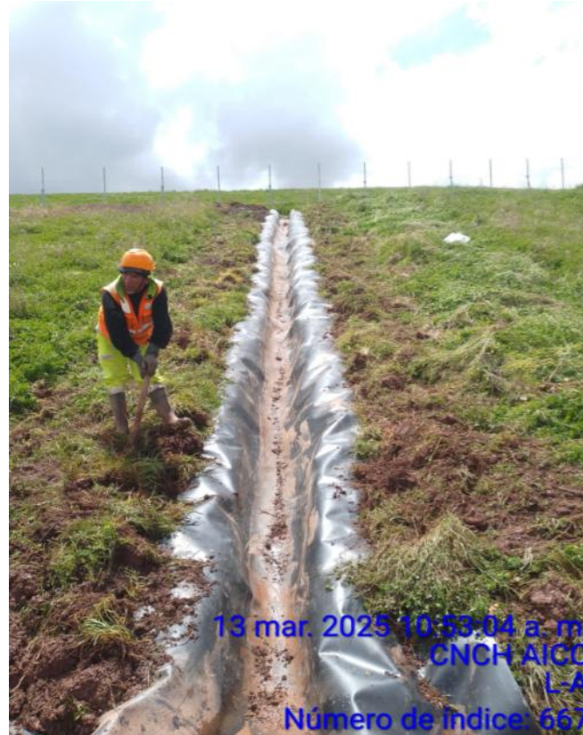
Mantenimiento y forrado de cunetas con Geomembrana.
