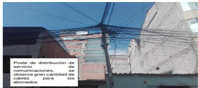
Cables en desuso y superposición de cableado corresponde a telecomunicaciones: telefonía, cable TV, fibra óptica
