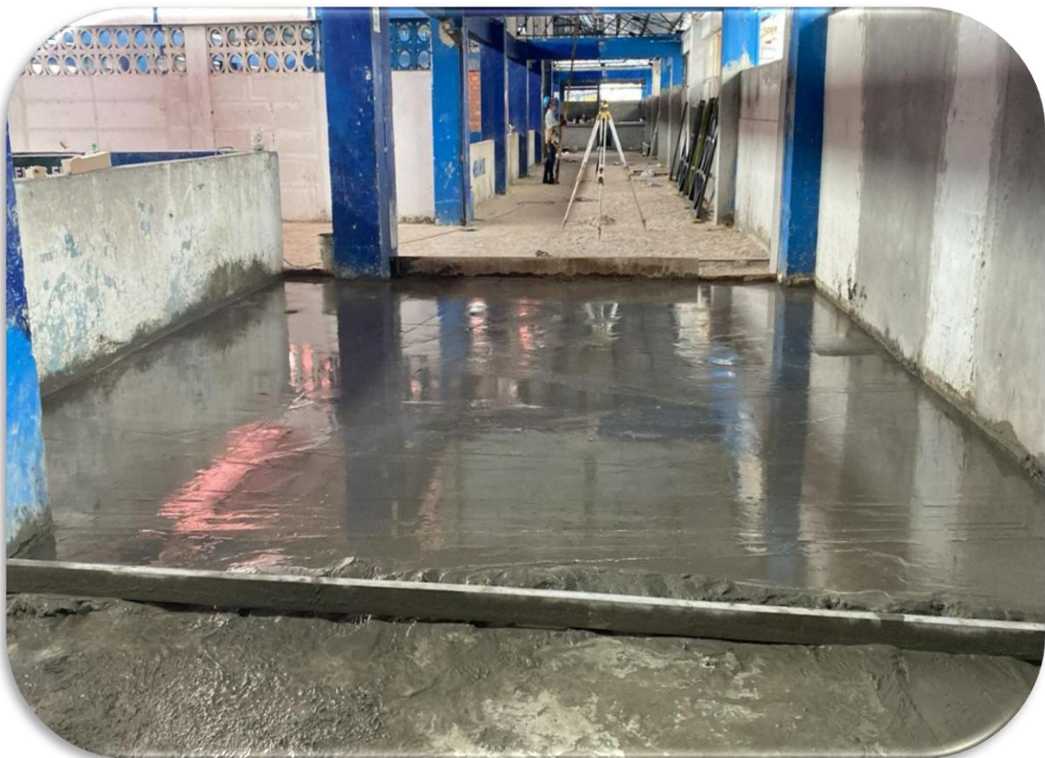
Vaciado de concreto - Losa
