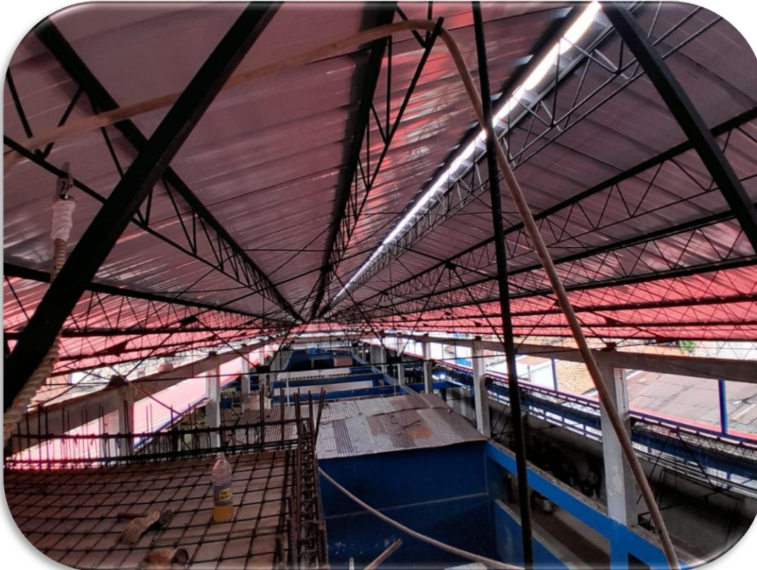
Cambio de Techo - Cobertura
