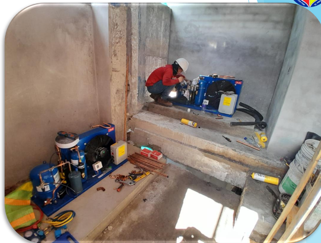
Instalación de condensadores - Área de Refrigeración (Frigorífico)
