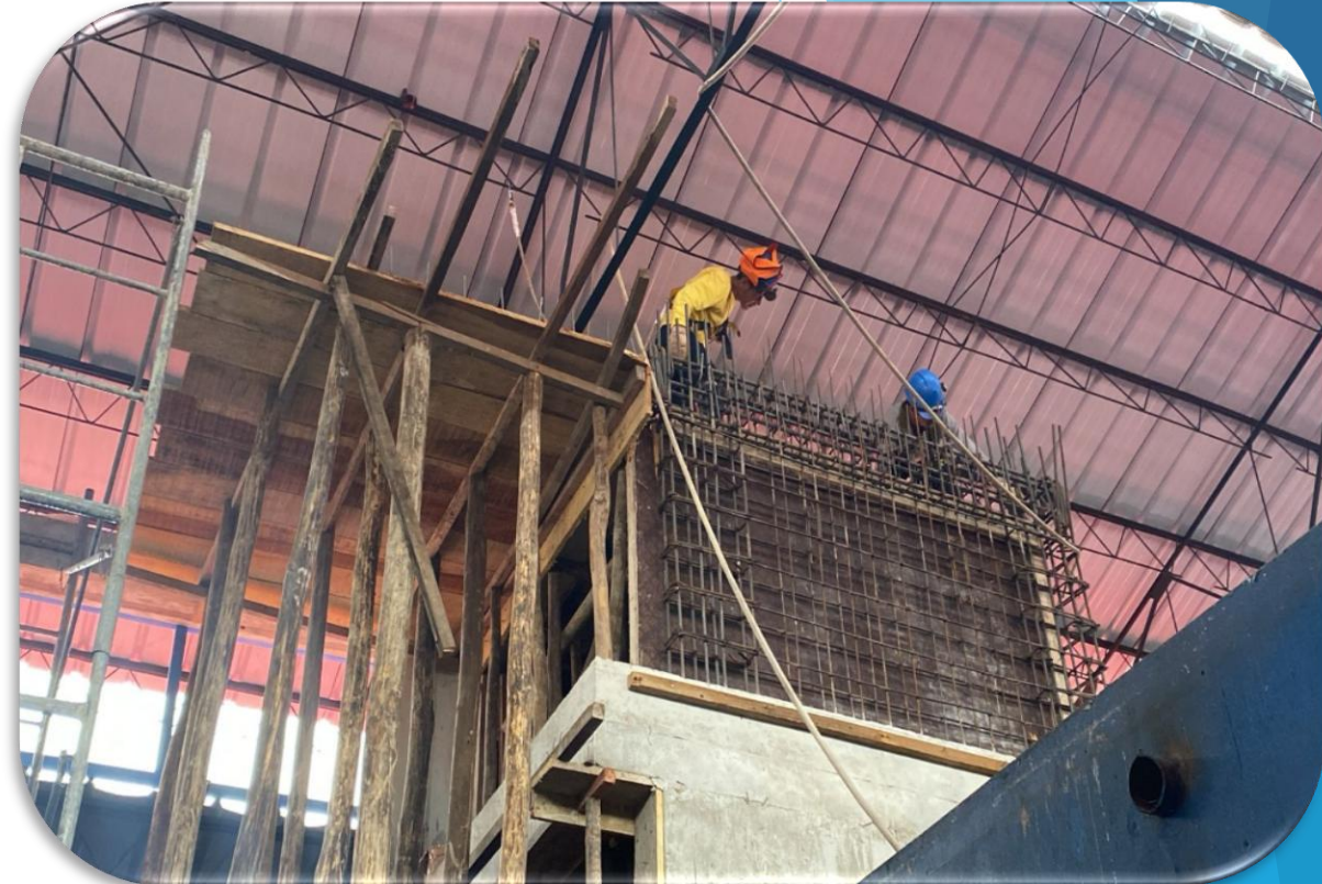
Estructura para el ascensor
