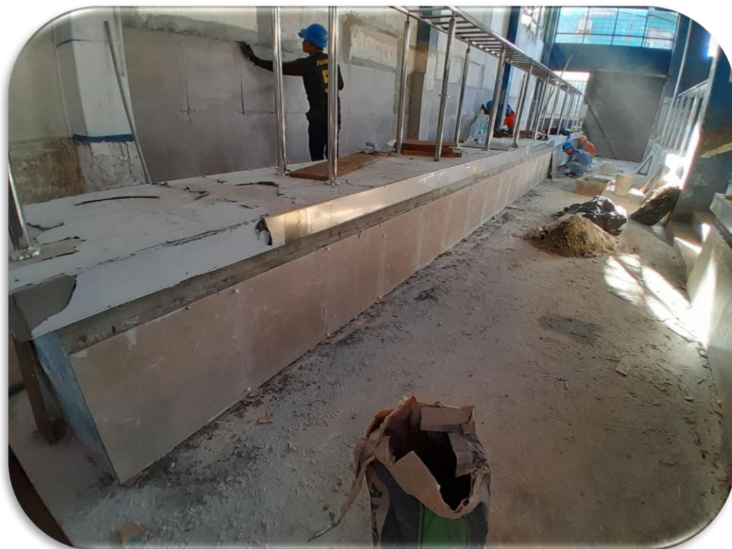
Enchape de porcelanato en mesas - Espacios de circulación horizontal
