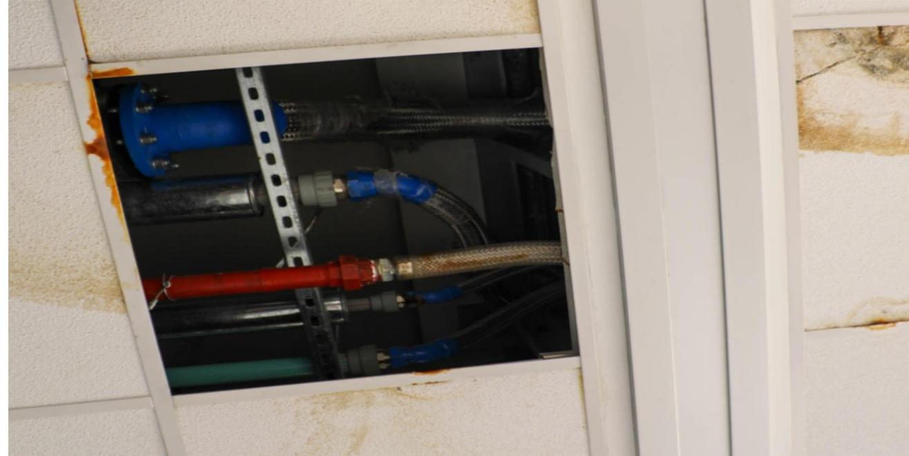
FUGA Y FILTRACIÓN DE AGUA FRÍA FRECUENTE EN LAS TUBERÍAS Y ACCESORIO DEL SISTEMA DE INSTALACIÓN SANITARIAS INCLUIDO VARIOS COLAPSOS: OCACIONANDO DAÑOS EN LOS ACABADOS
