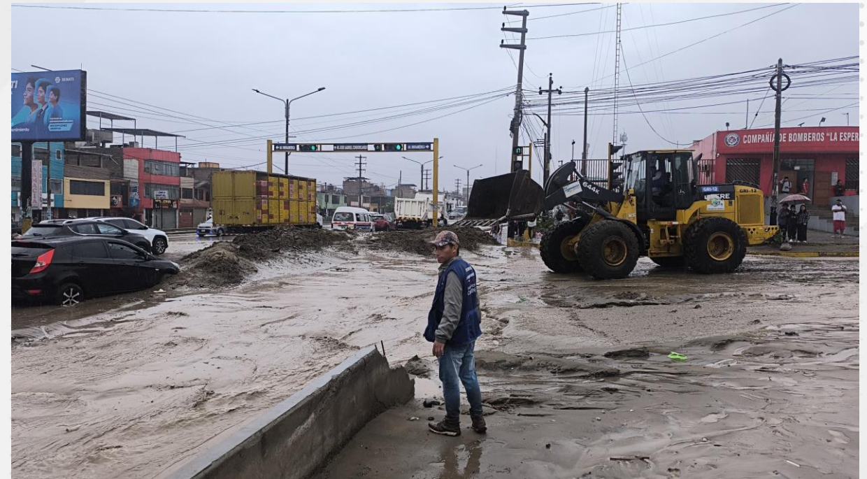
MAQUINARIA ATENDIENDO DE MANERA OPORTUNA
