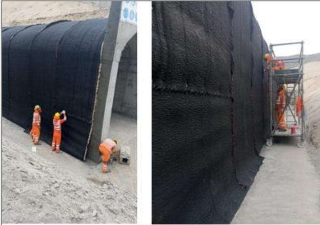
Colocación de geocompuesto en 90 m adicional de conducto cubierto
