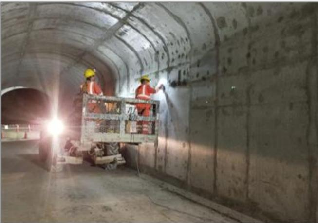
Acabado y sellado de juntas en losa de túnel
