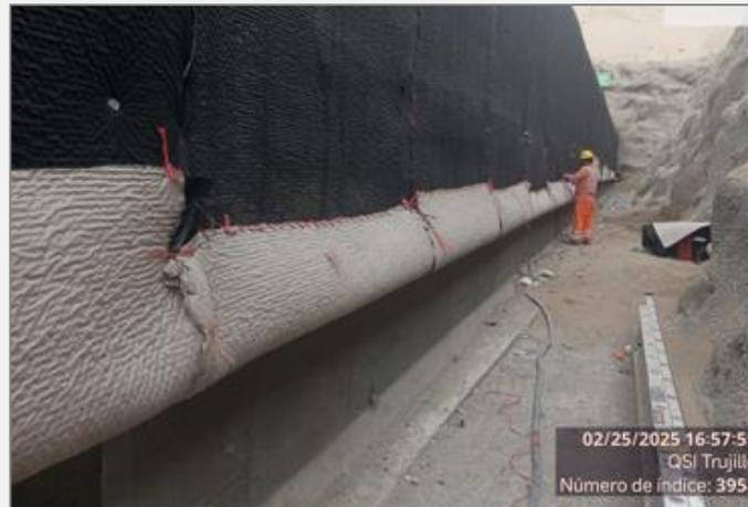
Instalación de tubería de drenaje en conducto cubierto
