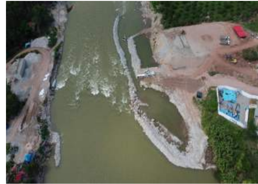
Ejecución de Dique de encauzamiento para la fabricación de la torre metálica para montaje.
