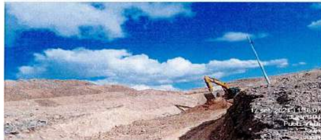
Imagen 16: Corte de material suelto entre la progresiva entre la progresiva 20+000 22+000
