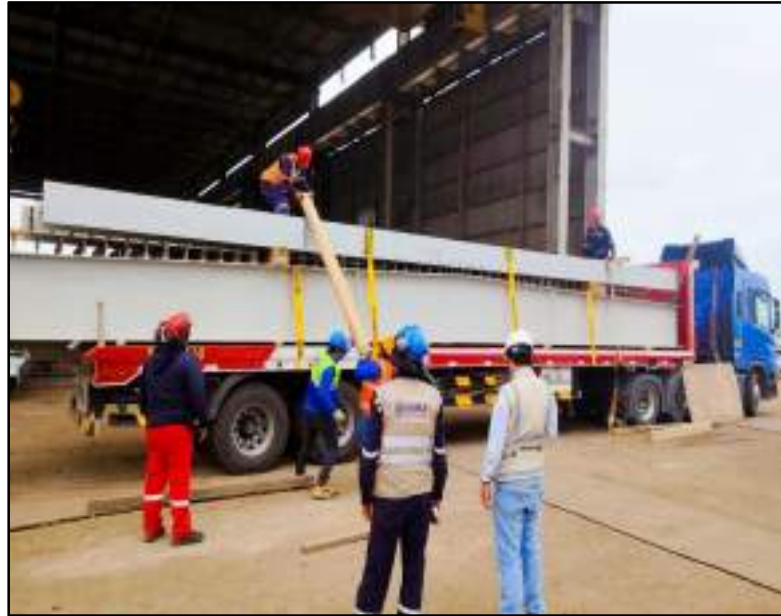
Culminado la ejecución de fabricación de la Estructura metálica del Puente – Proceso de Transporte
