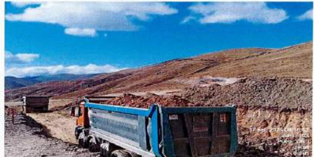
Imagen 16: Corte de material suelto entre la progresiva entre la progresiva 20+000 22+000
