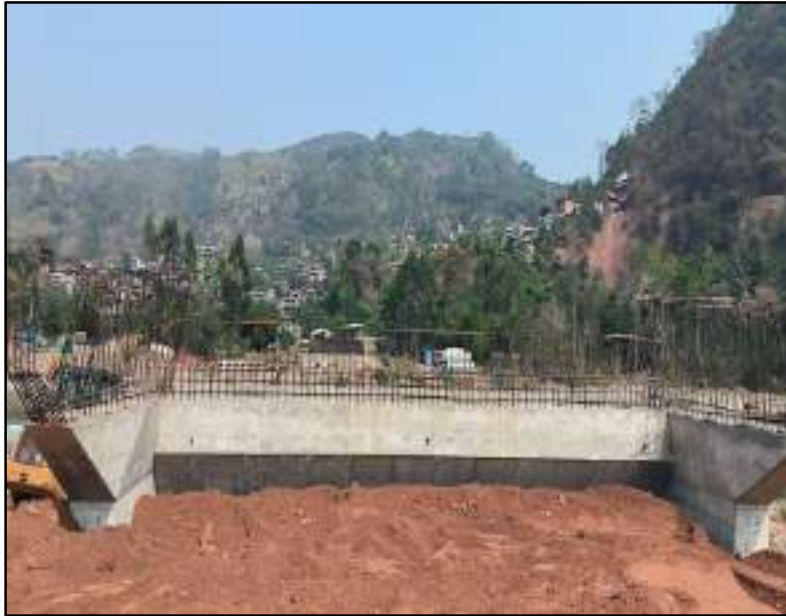
Culminado la Ejecución de Ambos Estribos del Puente
