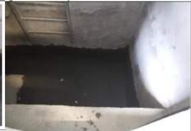
c) PRESENCIA DE NIVEL FREÁTICO EN EL SOTANO DE LA ESTRUCTURA
