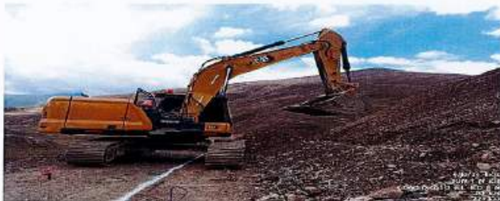
Imagen 14: Corte de material suelta entre la progresiva Km 20+000 – 22+000
