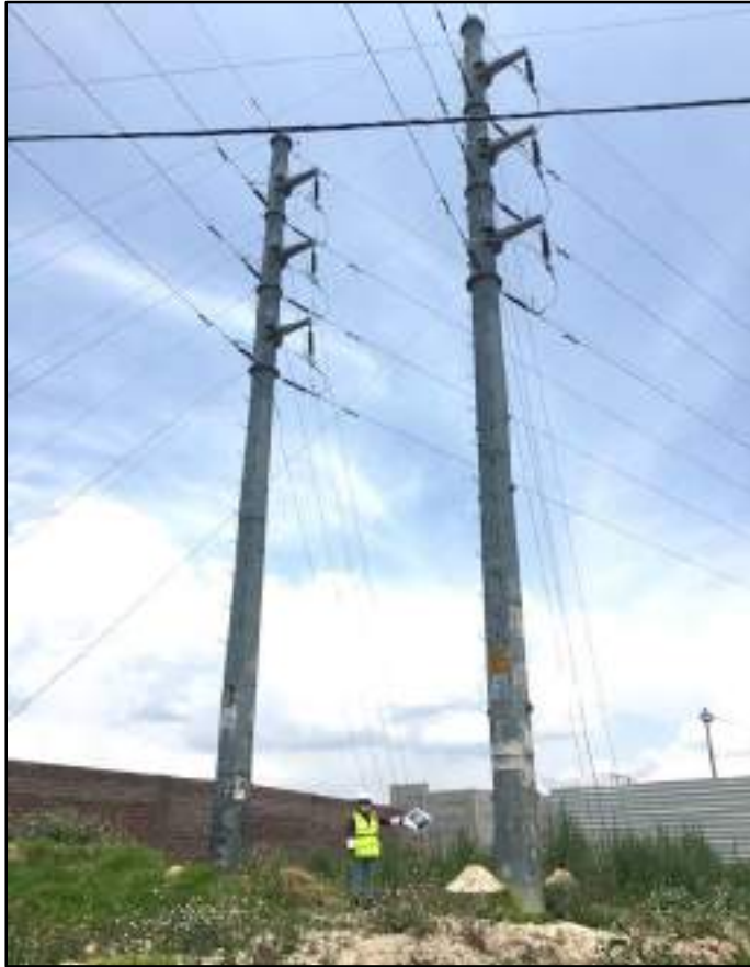
Torres de Alta Tensión que Interferían en el Acceso lado Izquierdo
