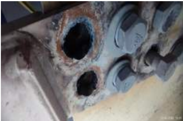
b) PLANCHAS METÁLICAS QUE SOPORTAN LOS DISIPADORES DETERIORADAS
