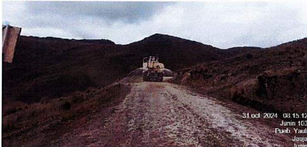
Imagen 13: Riego mediante el camión cisterna para el mantenimiento de la vía
