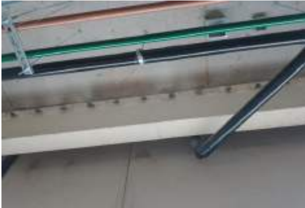
b) PLANCHAS METÁLICAS QUE SOPORTAN LOS DISIPADORES DETERIORADAS
