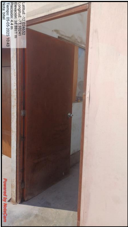
Cambio de chapa de puerta
