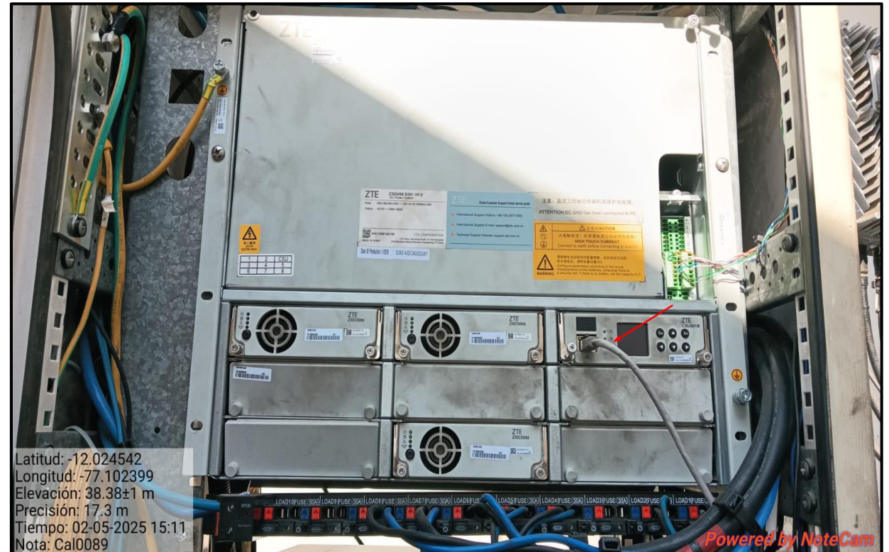
Instalación del cable después
