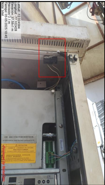
Instalación de sensor de puerta
