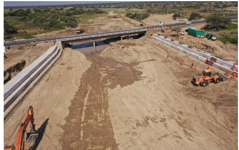
**Puente Motupe Km 822+725.** Protección de estribo del puente
