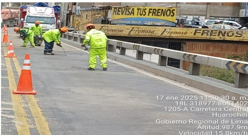
Mantenimiento de puente Ricardo palma, sello de fisuras en superficie de rodadura.
