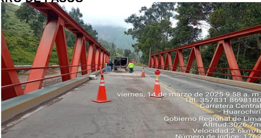
Reparación de Losa de Rodadura Puente Tamboraque III
