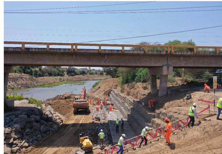
**Puente Ucupe Km 745+569. Protección de estribo y pilar del puente**
