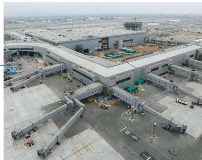
MANGAS DE ABORDAJE (TKE) 46 INSTALADAS
