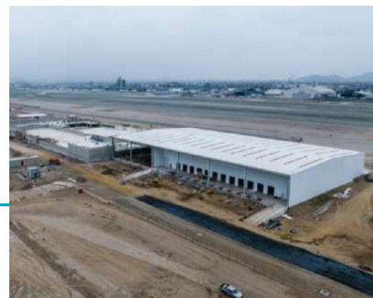
ZONA CARGA SUR Empresa peruana IKSA - US$ 19MM
