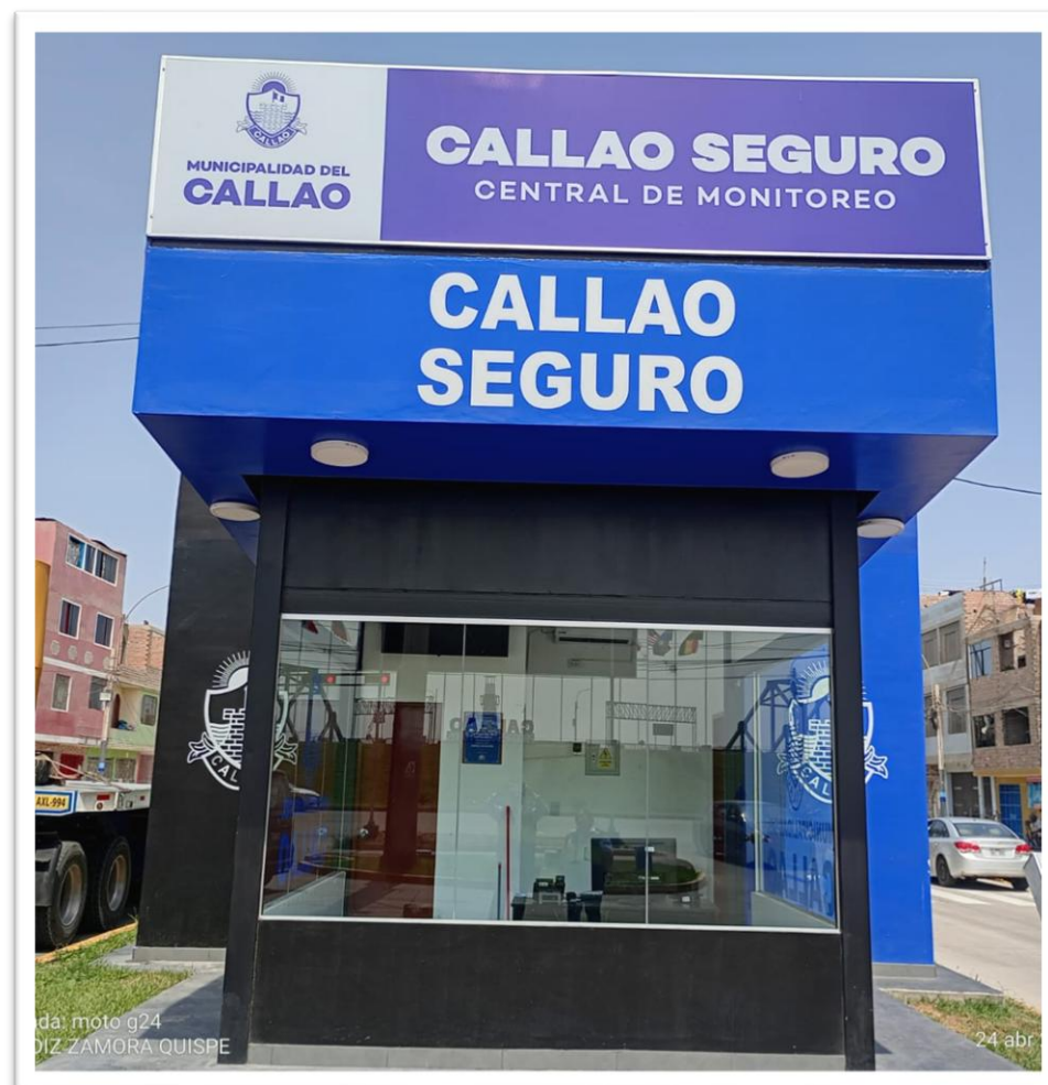
Av Morales Duarez con Nuevo Aeropuerto
