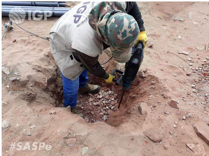
Personal del IGP efectuando la excavación para la construcción de un pilar.
