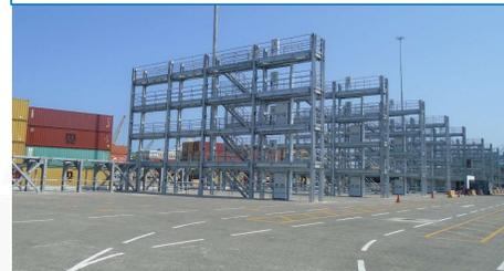
Estructura de diez (10) torres rack con tomacorrientes para almacenamiento de contenedores refrigerados.
