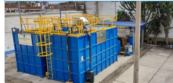
Implementación de una PTAR para el tratamiento del efluente industrial (lavaderos de equipos).
