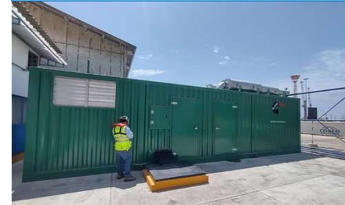
Respaldo de energía para la subestación eléctrica RSO, con el fin de garantizar el suministro eléctrico
