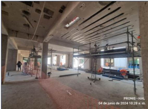
Pegado de Fibra de Carbono (FRP).
