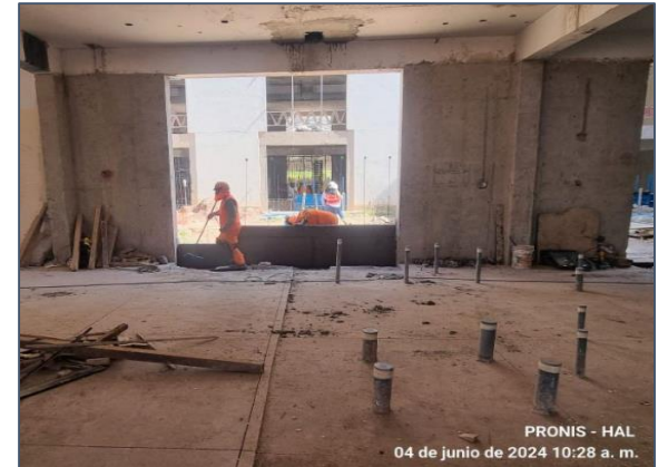
Muros perimetrales de los bloques.
