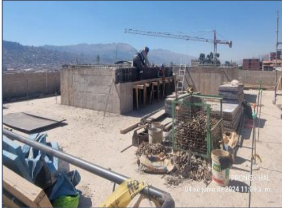
Armado de acero de techo de ascensor – Bloque 15
