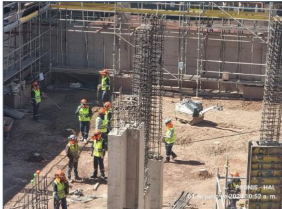
Armado y encofrado de vigas - Bloque 16
