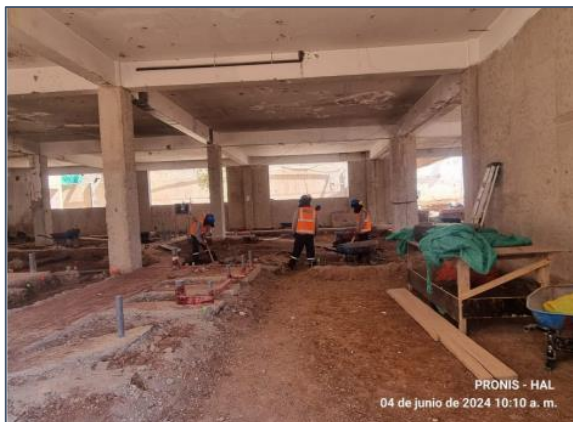
Remoción de suelo para reposición de falso piso
