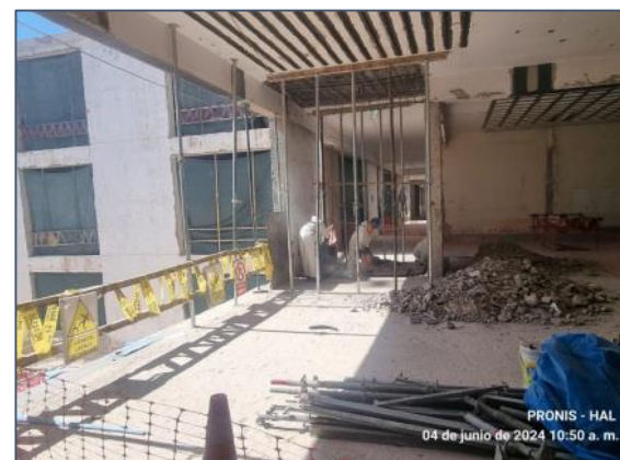
Demolición de viga y losa para reforzamiento
