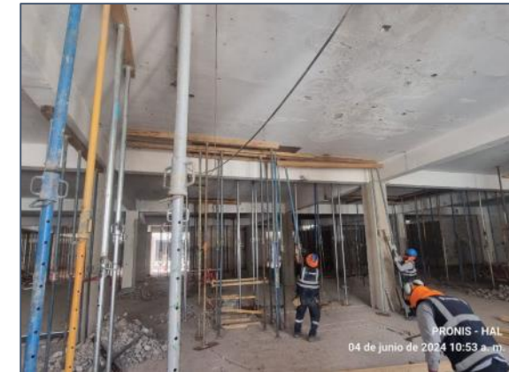
Apuntalamiento para luego iniciar demolición.
