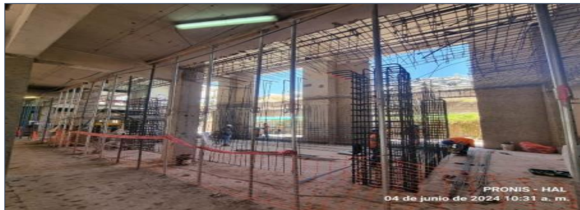
Colocación de acero de columnas y muros del bunker de braquiterapia
