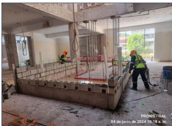
Tabiquería húmeda en interiores
