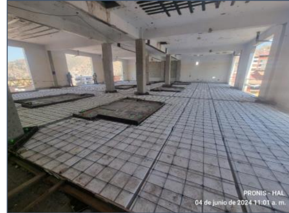
Armado de contrapiso
