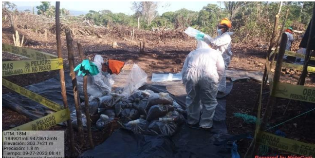
Trabajos de recolección de material vegetal y suelo contaminado con HC en el punto cero
