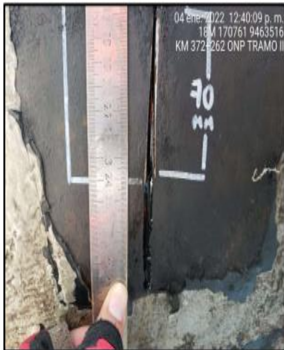
Fotografía 3. Corte C-1 – Vista de detalle.
