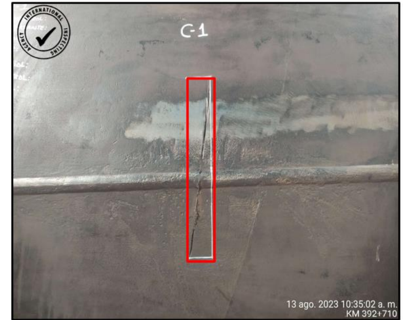
Fotografía 3. Corte C-1 – Vista de detalle.
