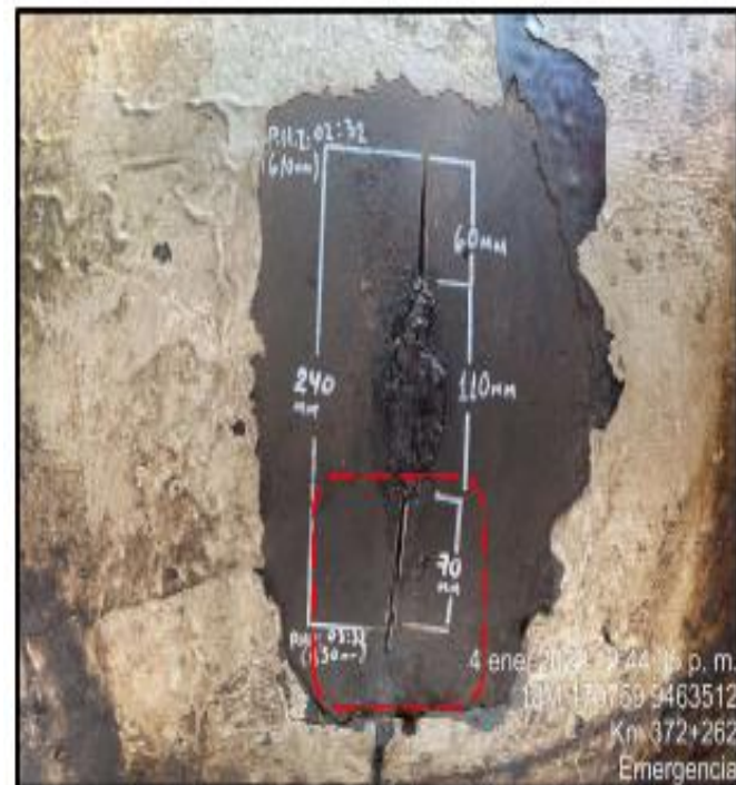
Fotografía 2. Corte C-1 pasante obturado con madera.
