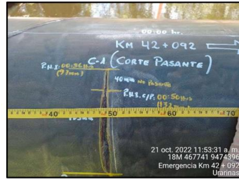
Fotografía 3. Corte C-1 – Vista de detalle.
