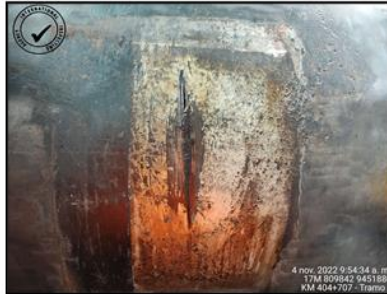
Fotografía 2. Corte C-1 pasante obturado con madera
