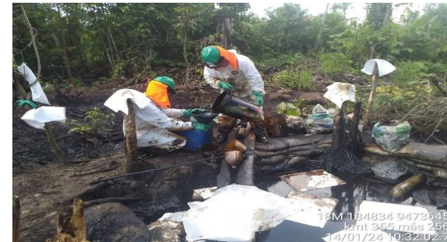
Nuevos trabajos de recolección de material vegetal y suelo contaminado con HC
