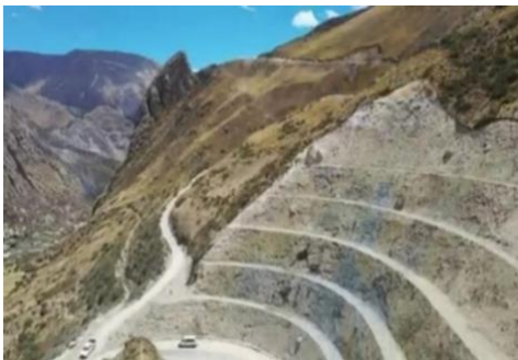
BANQUETAS ANTES DEL DERRUMBE
