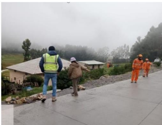
Imagen N° 01. Vivienda de propiedad de la familia Muruguza por debajo del nivel de la plataforma
