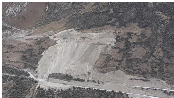
TERRENO AFECTADO POR EL DERRUMBE
