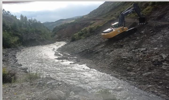
1.- Trabajo realizados en el Cruce Tingo Chico -chuquis km 1+100 eliminación, perfilado de talud y conformación de plataforma km: 1+200 eliminación de derrumbe, perfilado de talud y conformación de plataforma km:1+300 a 5+100 eliminación de derrumbe y conformación de plataforma.
