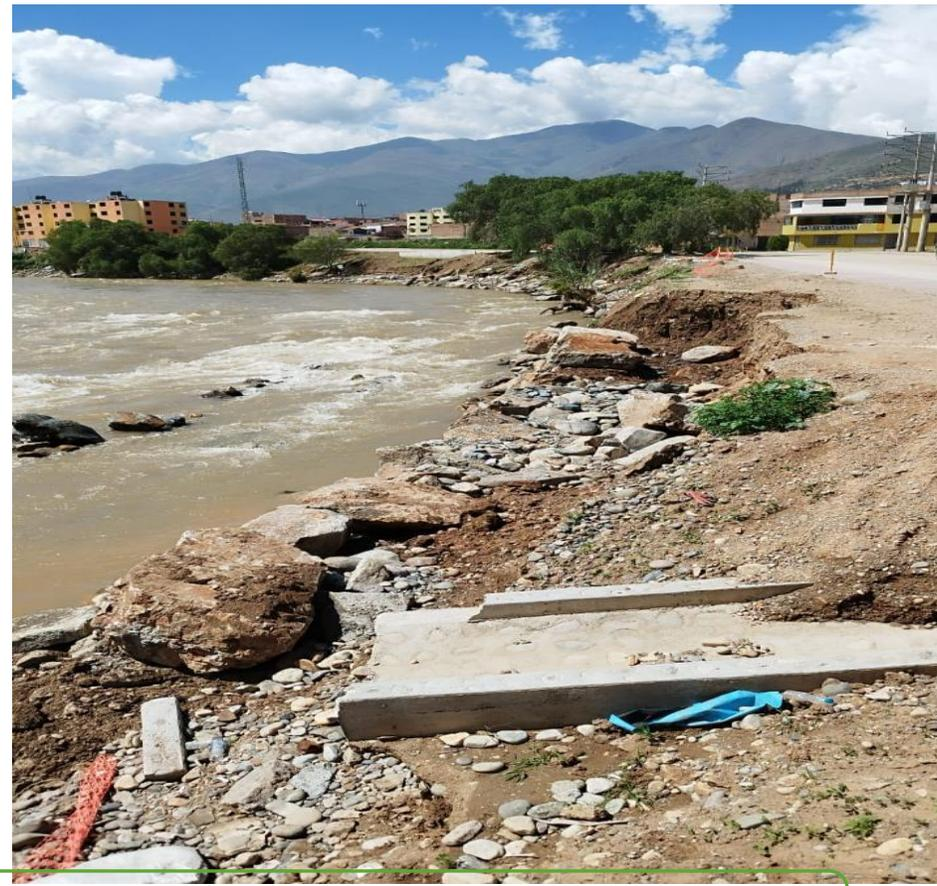
1.- Emergencia en el Talud en la Av. Walcker Soberón margen izquierda, debido a las intensas lluvias en la Región.
