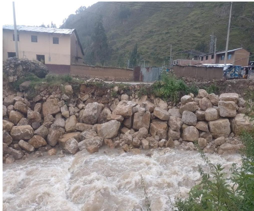
2.-Construcción de Muro de Enrocado para Protección del Talud y evitar el colapso de las viviendas.
