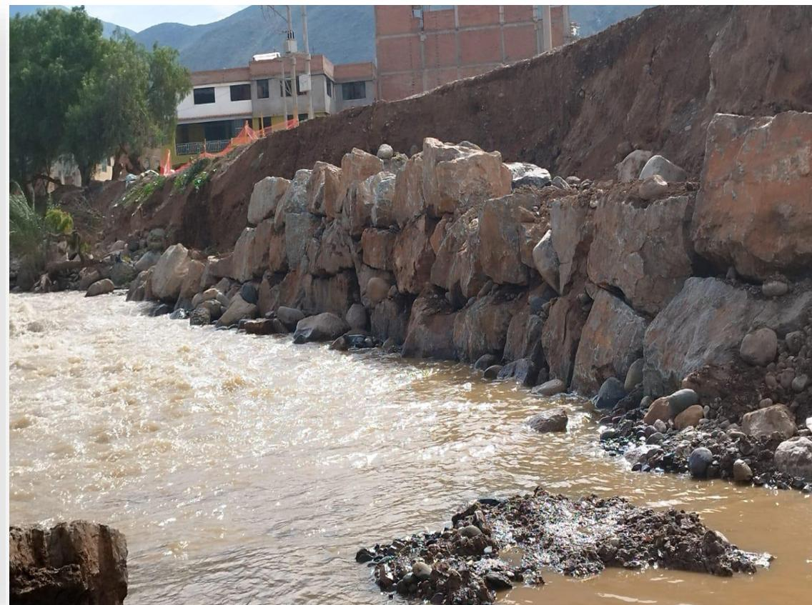
2.-Trabajos de Emergencia para la Protección del Talud en la Av. Walcker Soberón, a través de construcción de un enrocado.
