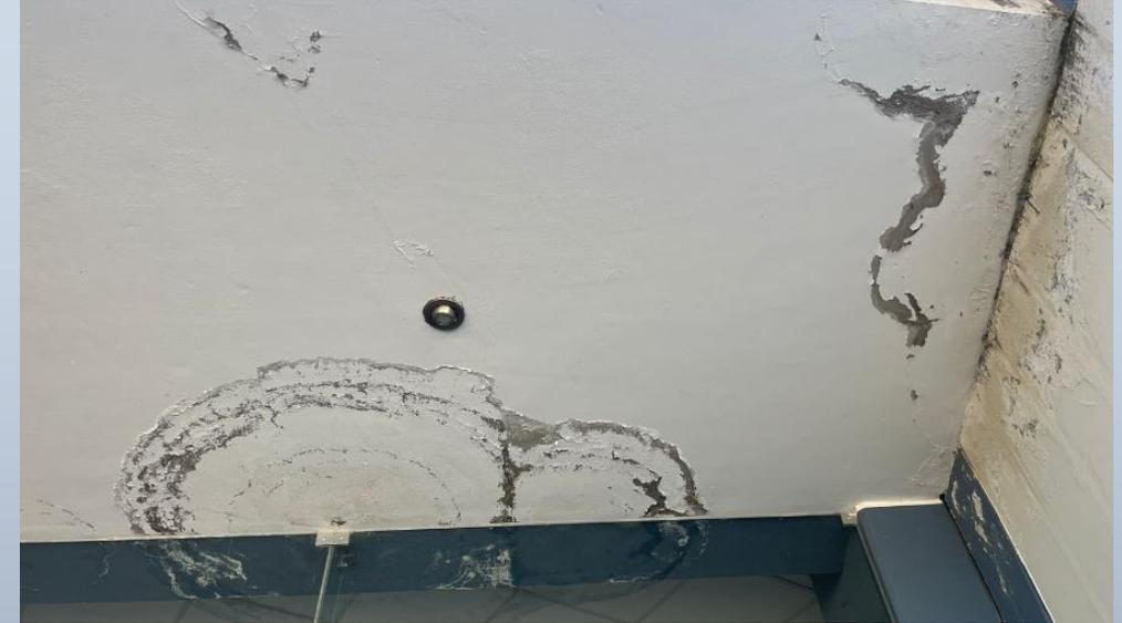
Deterioro de cubierta, desprendiendo de pintura en cielo raso
