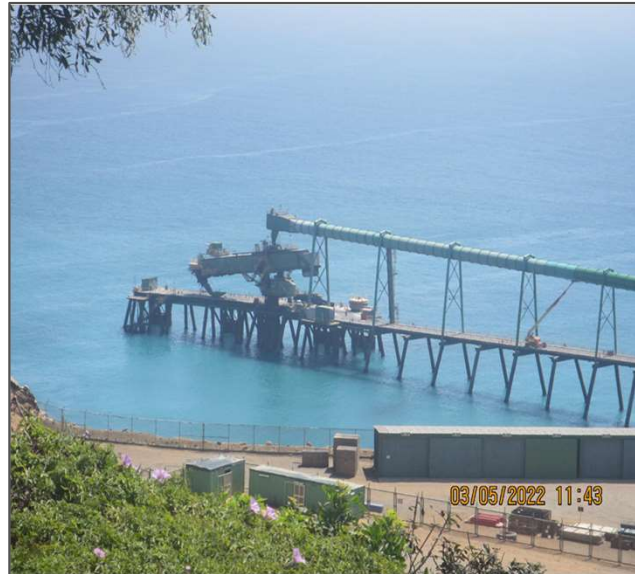
Vista panorámica del sistema de carga de buques
