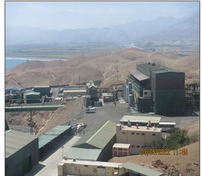
Vista panorámica de la planta de filtrado
