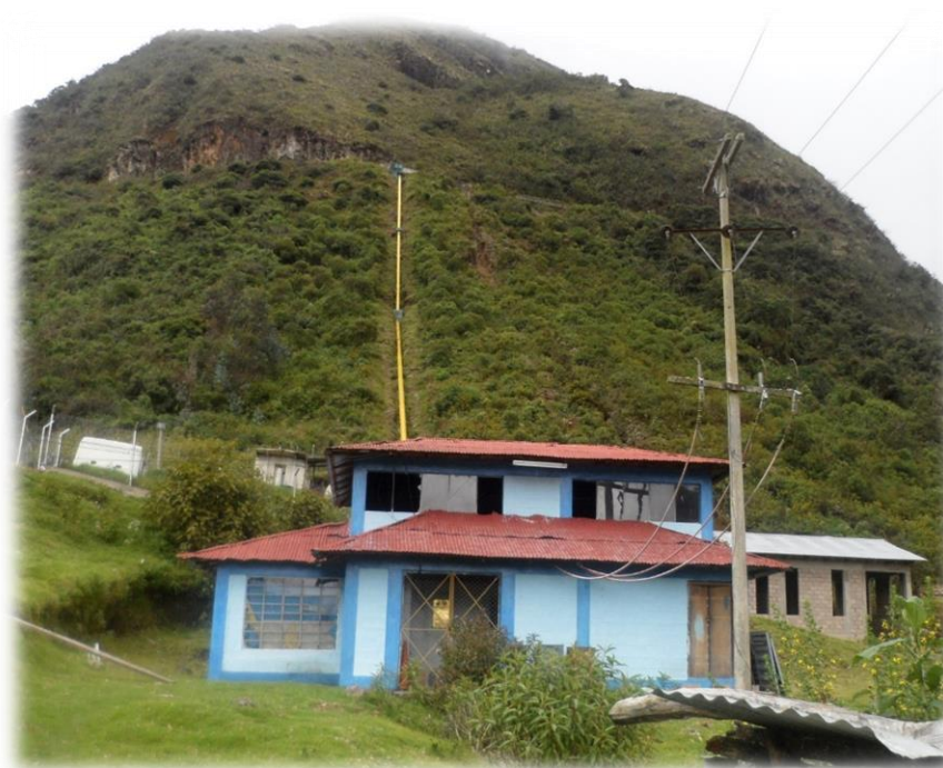
Casa de Maquinas de la Mini central Actual.
