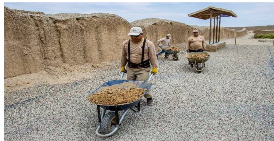
Jornada de limpieza y resane de material de sacrificio
