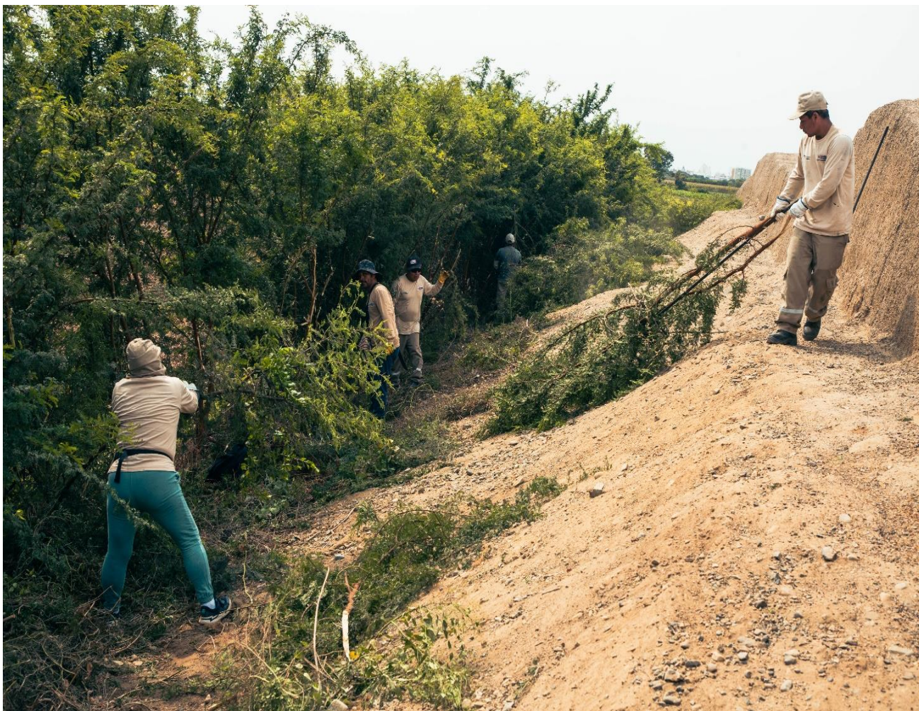
Retiro de maleza evita que la humedad afecte las estructuras edificadas en tierra.
