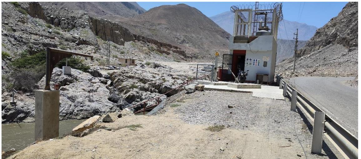
**Foto N° 05.-** Estación Condorcerro en el río Santa; aguas abajo de la confluencia con el río Tablachaca. Predominan los afloramientos de rocas intrusivas graníticas que se muestran diaclasadas y conformando taludes superiores a 30 grados.
