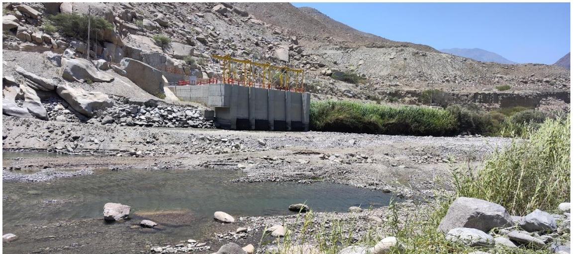
**Foto N° 08.-** Aguas arriba de la Bocatoma CHAVIMOCHIC, obras de Derivación durante el proceso constructivo. Flanco derecho del valle con afloramientos de rocas graníticas fracturadas y diaclasadas que merecieron la instalación de Medidas de Estabilización (vallas, mallas y anclajes).
