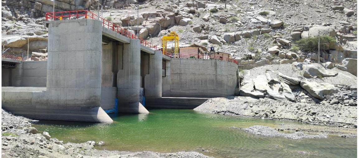
**Foto N° 07.-** Bocatoma CHAVIMOCHIC, captación ubicada en la margen derecha del Santa, a continuación de la confluencia de la quebrada Sin Nombre (margen izquierda). Corresponde a la ubicación de la Captación Única, en tal sentido se requiere evaluar la incidencia de la quebrada Sin Nombre en la seguridad de las obras.
