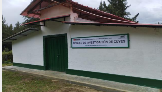
Módulo de cuyes EEA Baños del Inca
