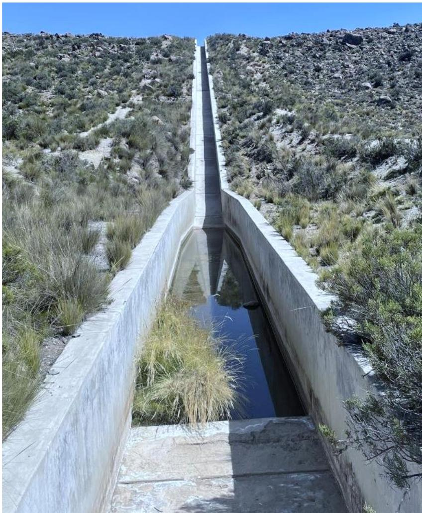
El proyecto “MEJORAMIENTO DEL SERVICIO DE PROVISIÓN DE AGUA PARA EL SISTEMA DE AFIANZAMIENTO DE LA LAGUNA ARICOTA – SUBSISTEMA TACALAYA DEL DISTRITO DE CAMILACA-PROVINCIA DE CANDARAVE” tiene como objetivo el mejoramiento del sistema captación y conducción del canal Tacalaya, así como sus obras de arte complementarias, con la finalidad de lograr el afianzamiento de la laguna de Aricota con un trasvase de 5 MMC.
