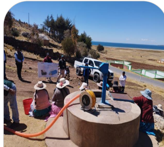
Mantenimiento y rehabilitación de pozos
