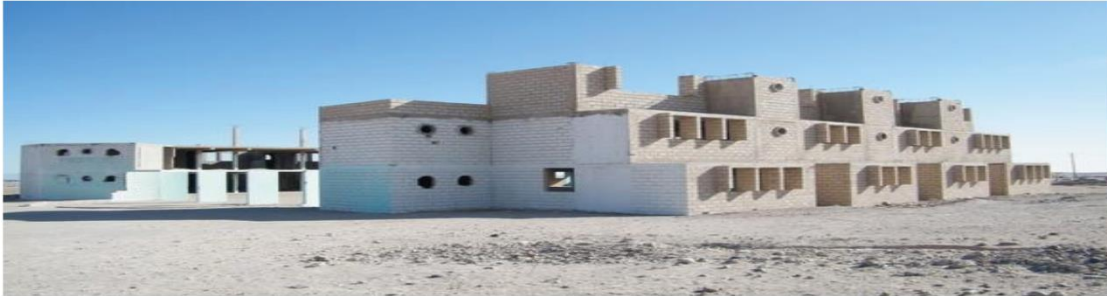
Edificación en el sector de Ciudad Perdida, distrito de Majes. Foto: Difusión
