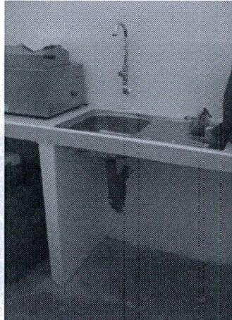
Foto 25 – vista de los puntos de agua acondicionados para el funcionamiento en esta unidad, se observa que los aparatos sanitarios no corresponden según norma.
