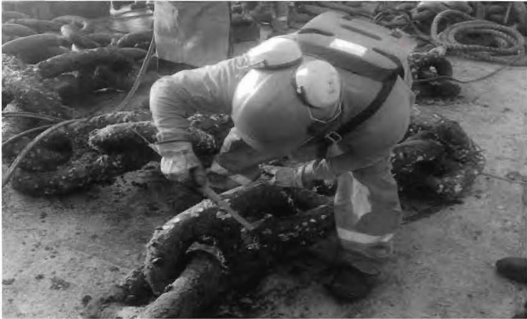
Figura 30. Eslabones de calibración que pertenece al tramo de pendura en muy mal estado de conservación.
