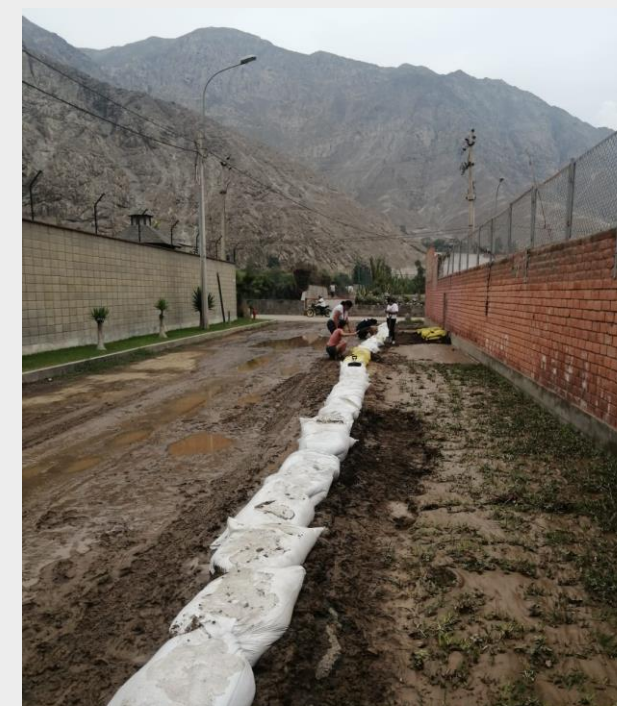
Instalación de sacos de arena
