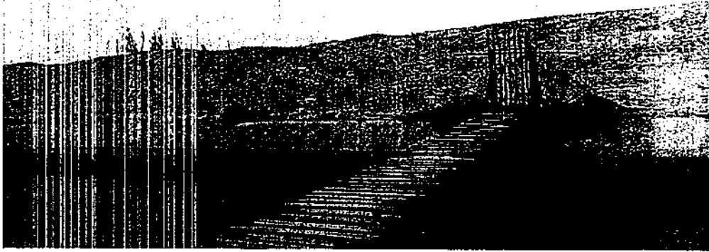
Presencia de puente rústico formado por tablas y palos.
