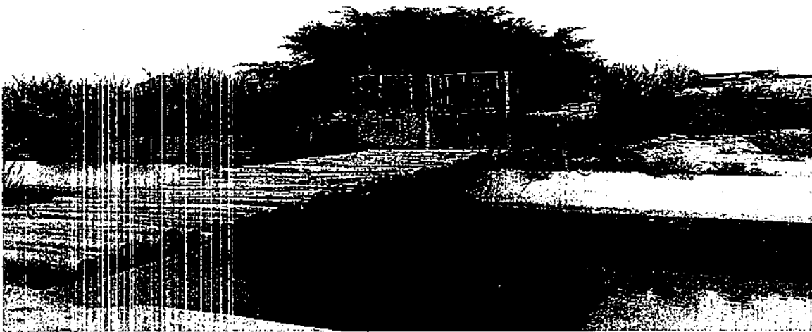
Presencia de puente rústico formado por tablas y palos.
