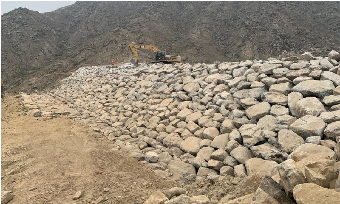
Fotografía: Dique 17 aguas abajo
