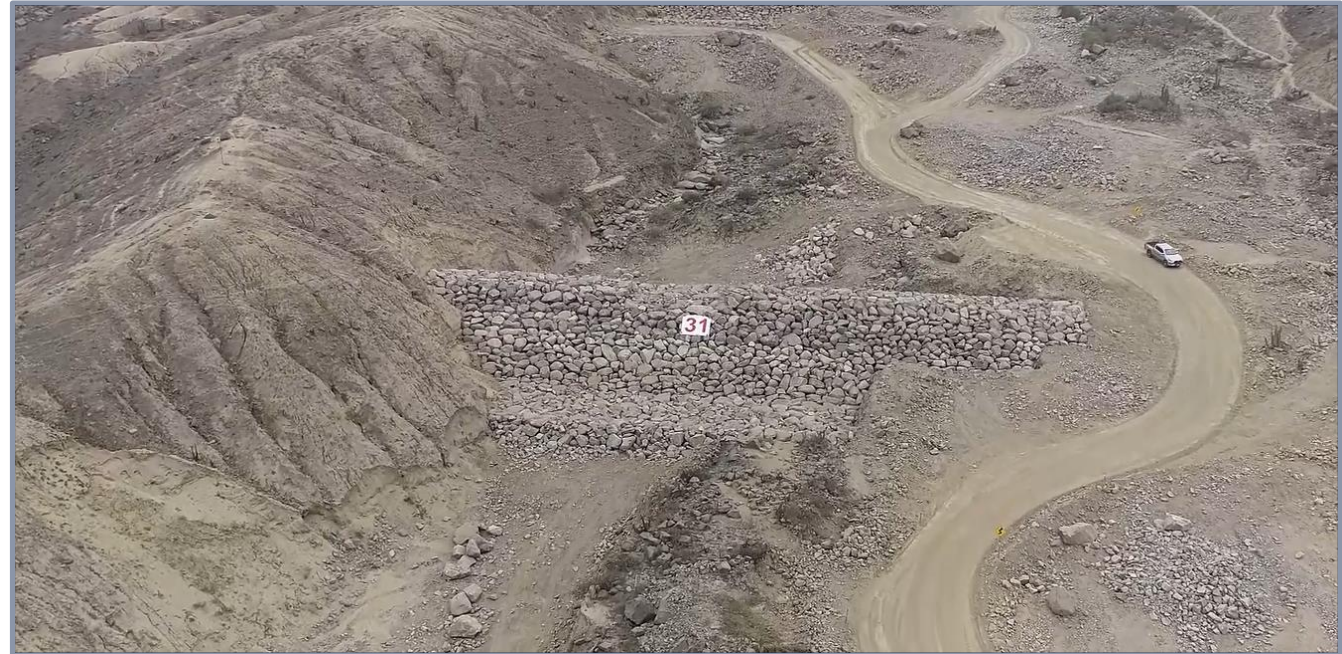
Dique: Construcción de Dique 31 | Terminado
