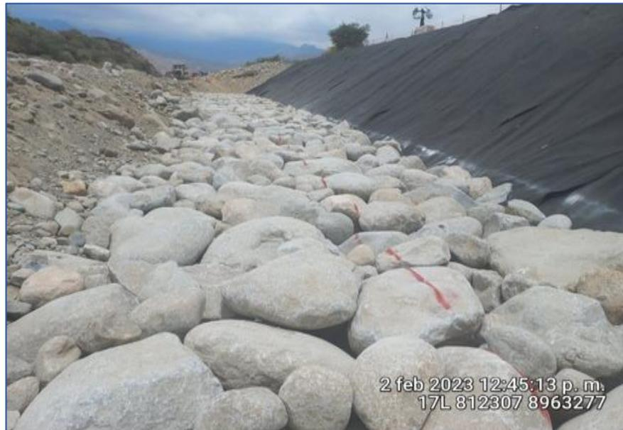
TRABAJOS DE INSTALACION DE GEOTEXTIL Y ENROCADO DE UÑA DIQUE 21
