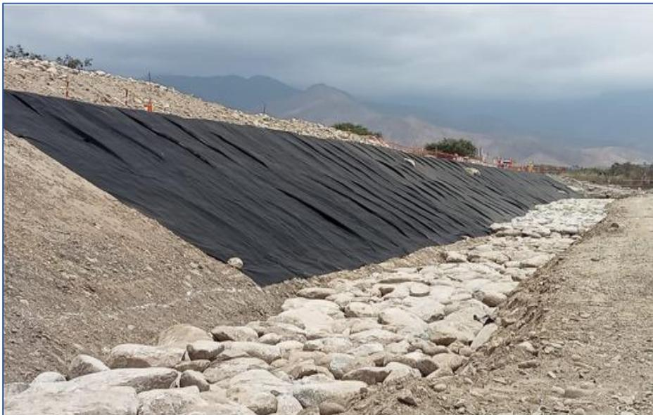
TRABAJOS DE INSTALACION DE GEOTEXTIL Y ENROCADO DE UÑA DIQUE 20 EN PROCESO
