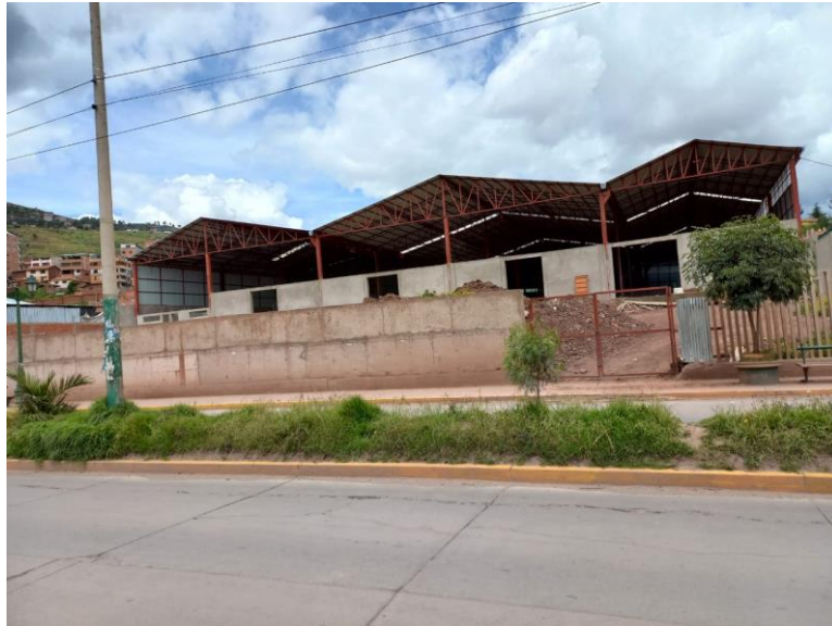
SUPERMERCADO ORION EN CONSTRUCCION (9)
