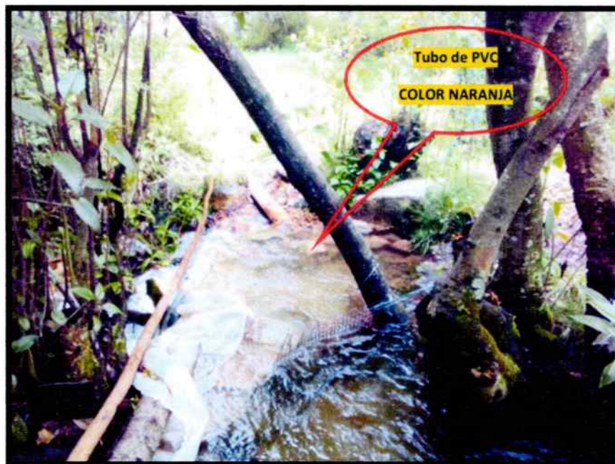
Figura N° 01, Evidencia lo precario que es esta captacion de Pumahuanca, mostrando un tubo PVC, quien capta y conduce hasta el buzón de recolección.
