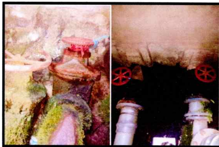
Figura N° 04, Evidencia la caseta de valvulas en esta inundacion.
