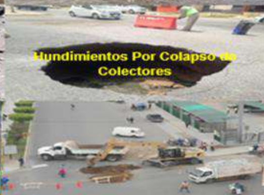
Colapso del Sistema de Alcantarillado Sanitario
