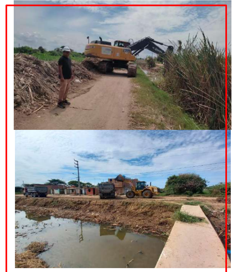
Dren 5000 en el distrito de Monsefu
