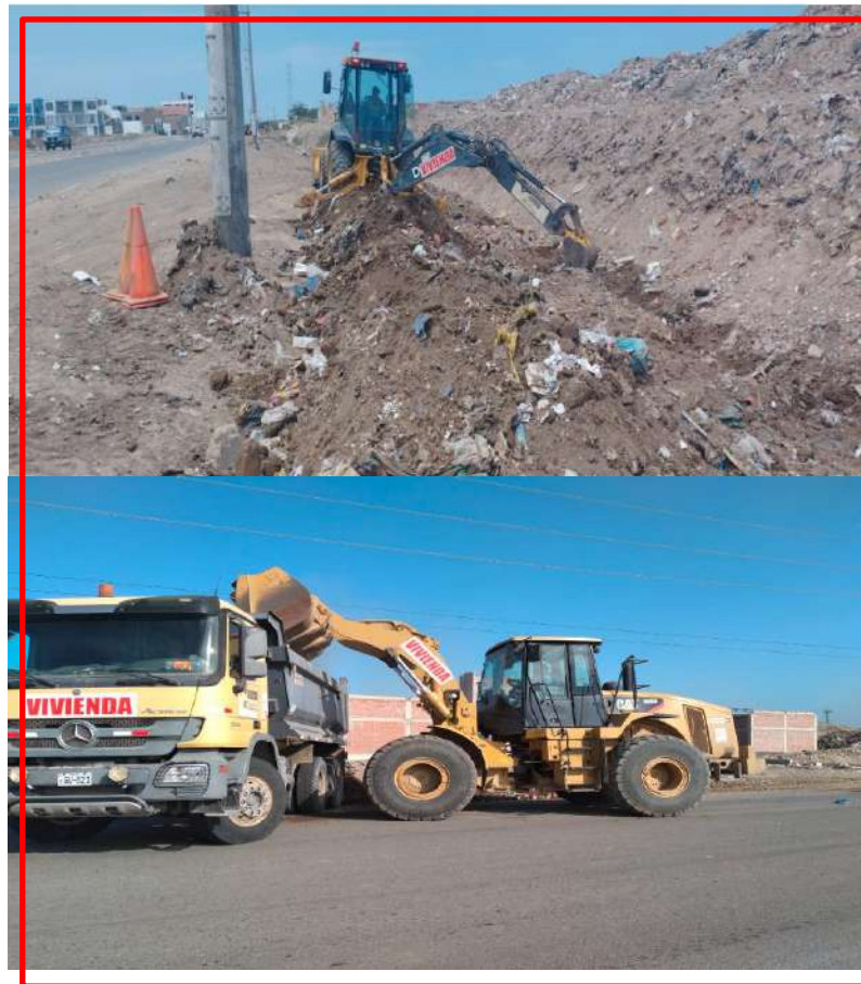
Dren 5200 en el distrito de La Victoria
