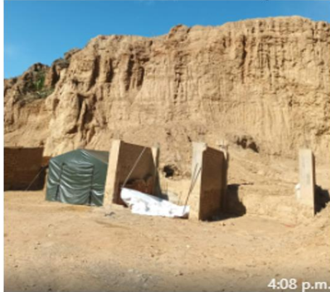
Construcción de viviendas al costado del cause
