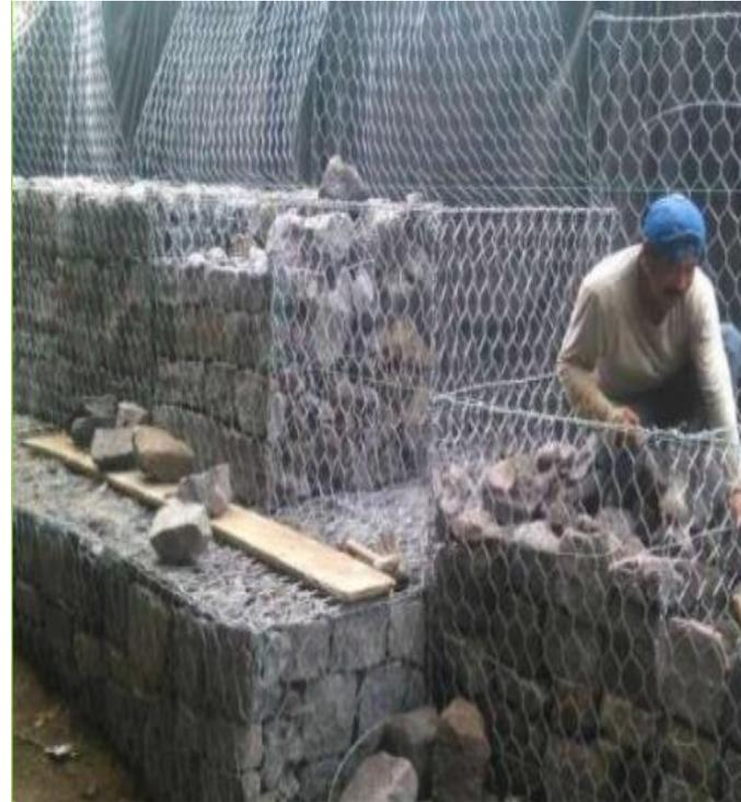
visualización de los tipos de Muros Gaviones para la protección de la defensa ribereña en un futuro.
