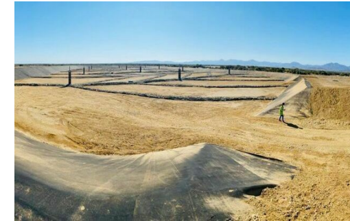
RELLENO SANITARIO DE TALARA
