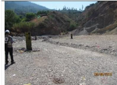
Fotografía N° 05: Zona soterrada con instalación de chimeneas en la plataforma del área degradada por residuos sólidos- Botadero Quitasol.
