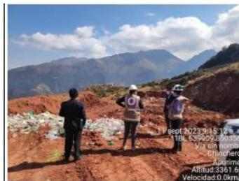
Fotografía 03: Residuos expuestos a la intemperie sin acción de esparcido y compactación en el ADRS
