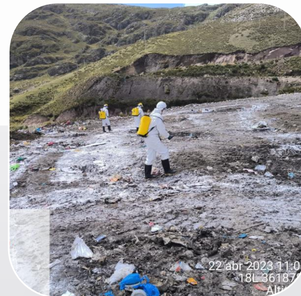
Tendido del material de cobertura
