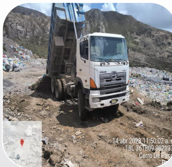
Disposición con material de cobertura
