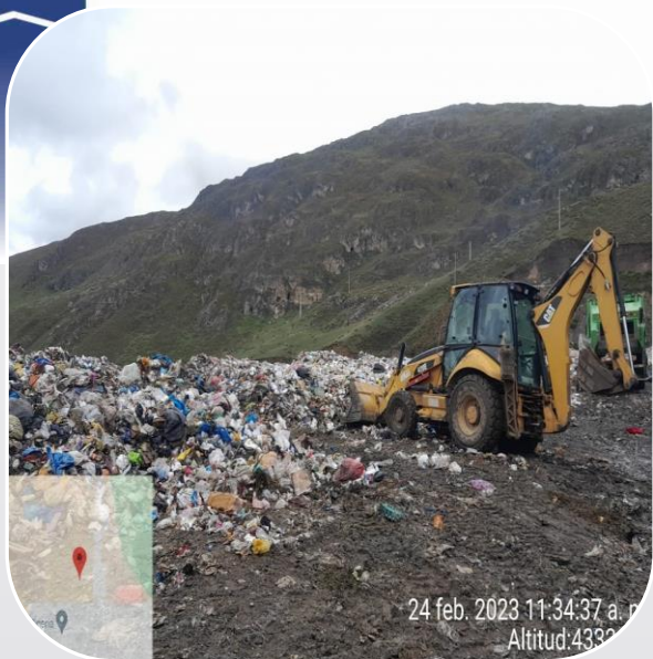
Limpieza con retroexcavadora
