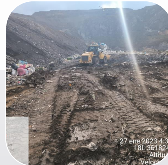
Tendido del material de cobertura
