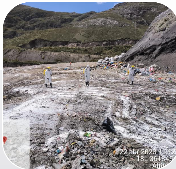
Disposición con material de cobertura
