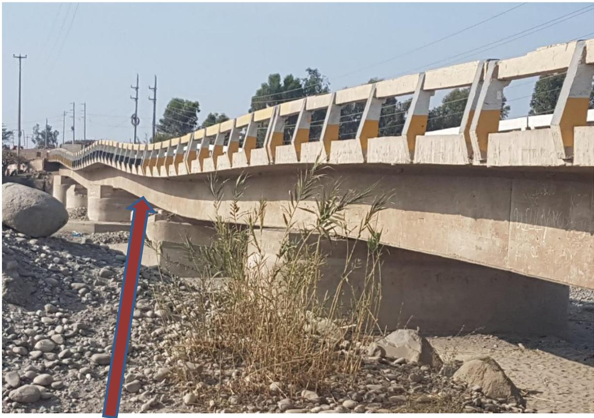
**En esta foto se aprecia el hundimiento o asentamiento del puente CHAMORRO**
