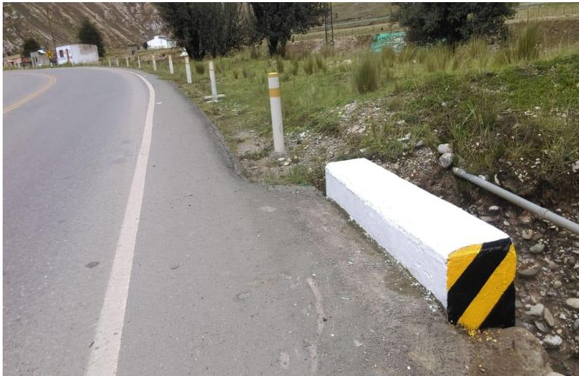
Sub tramo3: Cabezal de alcantarilla como elemento de encarrilamiento
