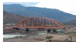
Puente Antonio Raimondi y Accesos
