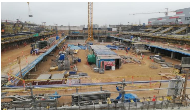
Julio 2018: Estructuras completas del Centro Acuático, Velódromo, Polideportivo 3, Estadio y Pista de calentamiento y Bowling para VIDENA.
