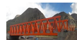
Puente Carrozable de Integración en el C.P Unión Soratira
