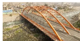
Puente Ñaña y accesos
