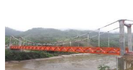
Puente Carrozable sobre el Río Perené
