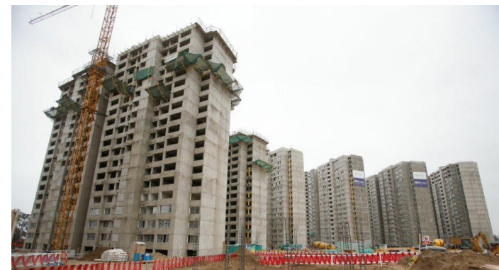
Julio 2018: Construcción de la última torre de la Villa de Atletas.
