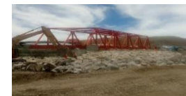
Puente Tanana y Accesos
