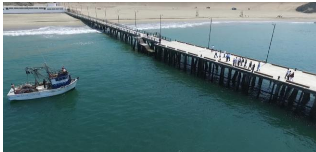
Fig. N°05 Aproximación de la embarcación hacia la zona de la plataforma baja del muelle
