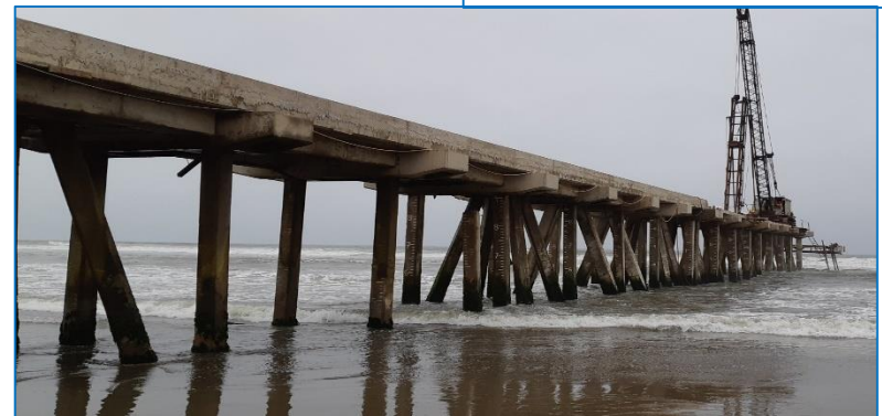
Avance en la ejecución sobre zona de rompientes, eje 120
