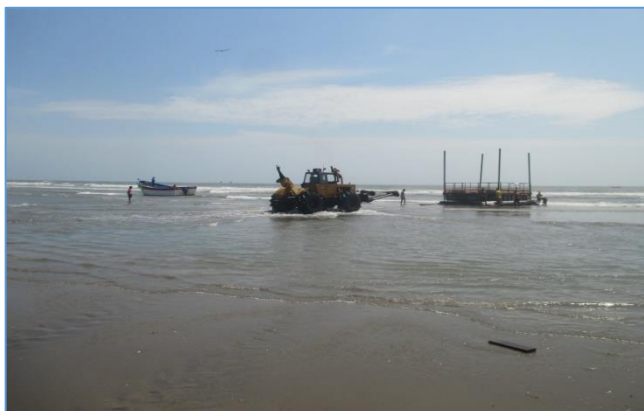
Remolque de barcaza para realizar sondeos en el suelo marino.
