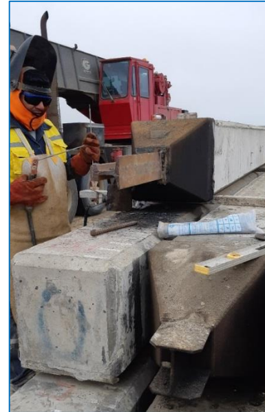
Reforzamiento de puntas con riel de 80 lbs /yda
