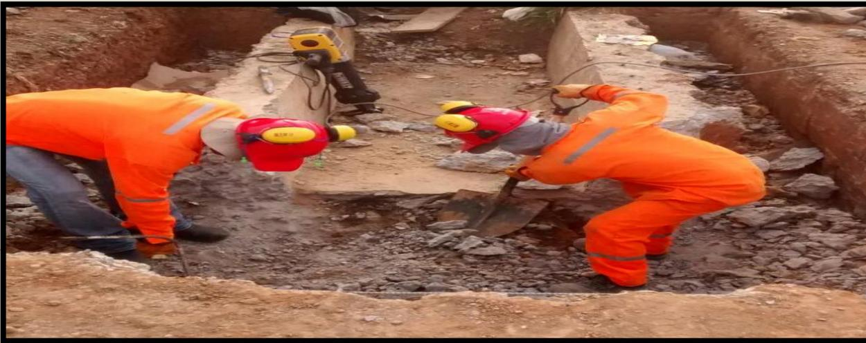
DEMOLICION DE CANALES DE CONCRETO CON ROTOMARTILLO
