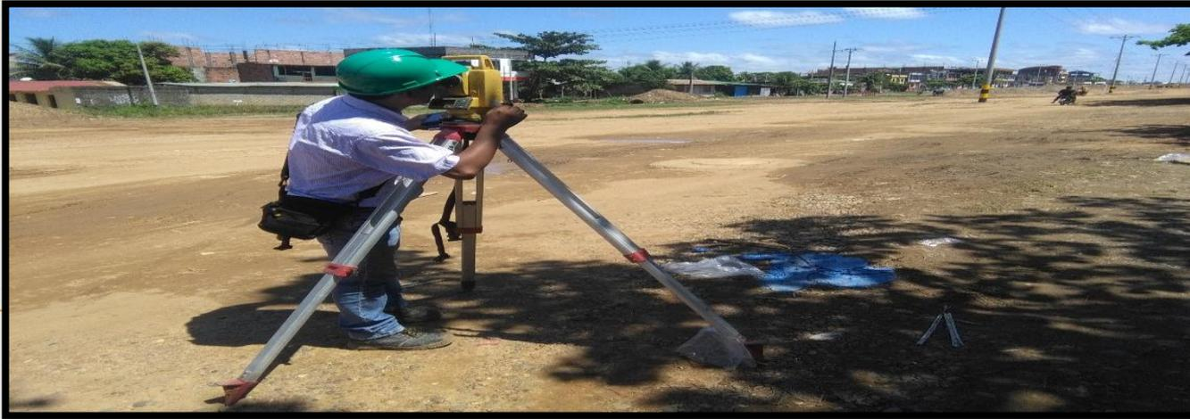
SE OBSERVA AL TOPOGRAFO REALIZANDO TRAZO Y REPLANTEO DE LINEA DE CONDUCCION Y ADUCCION
