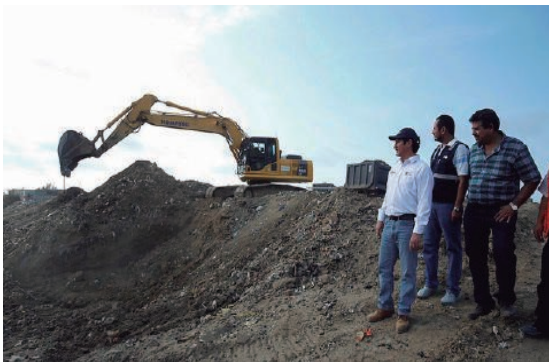
Inspeccionando junto al Viceministro de Construcción y Saneamiento Juan Haro, los trabajos de descolmatación en Tumbes.
