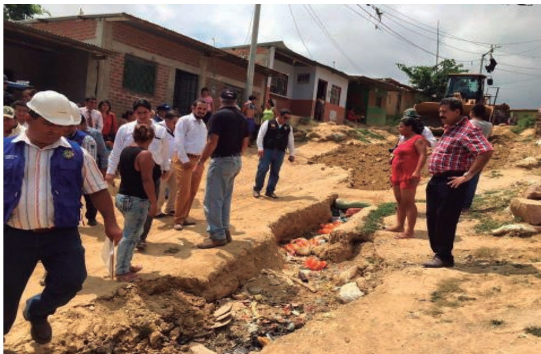
Realizando visita de inspección a los trabajos de descolmatación de la quebrada Salamanca, actividad ejecutada por la Municipalidad de Tumbes con la maquinaria del programa “Nuestras Ciudades” del Ministerio de Vivienda, Construcción y Saneamiento.
