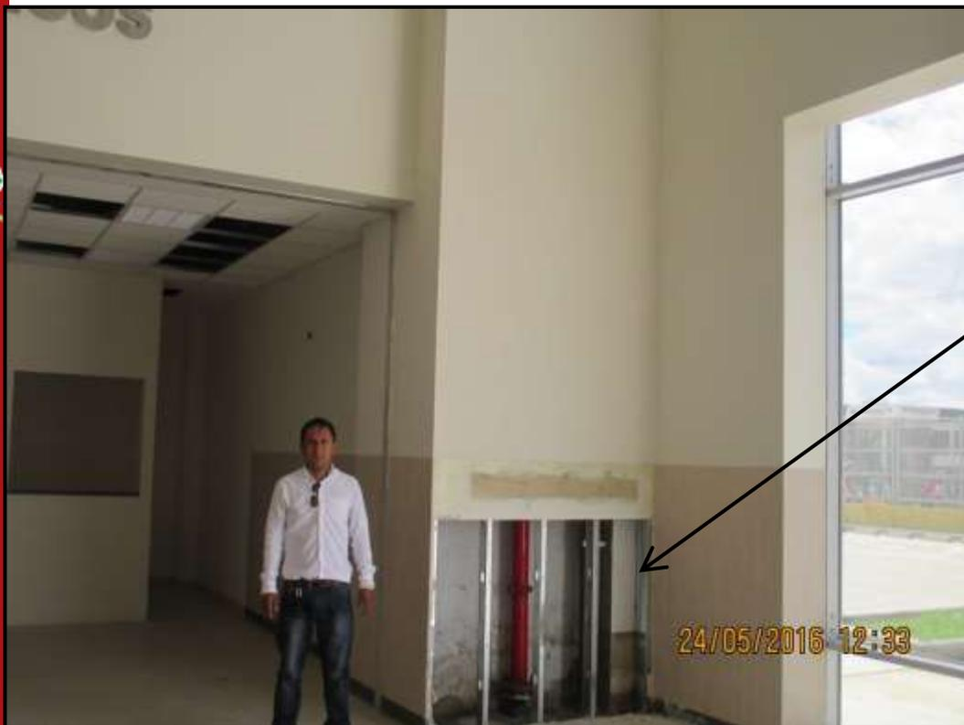
**Muro deteriorado en el ingreso principal por filtración de agua del sistema contra incendio**
