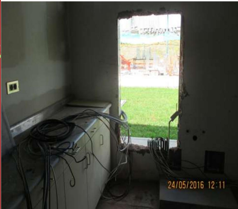
**Cables de media tensión que se están instalando falta colocar bandejas y cerrar ductos**
