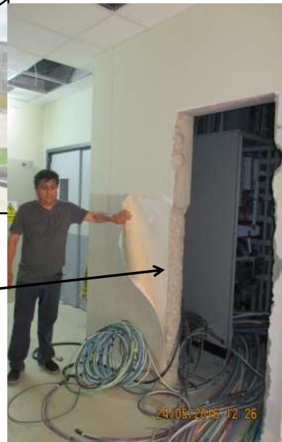
**Puerta retirada, muro picado, zócalo de vinílico deteriorado para ingresar gabinete eléctrico, cables de media tensión por colocar Contratista no tuvo en cuenta dimensión de gabinetes y puertas**
