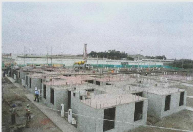
Foto N° 16: vista del encofrado de muros de la Mz J
