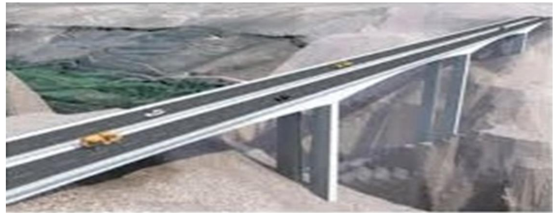
PUENTE DE LA CULTURA LONGITUD 405 Metros
